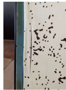
U14 fronte dettaglio
